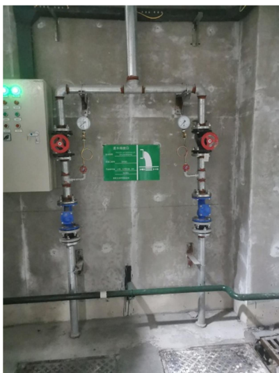
污水排口标识
