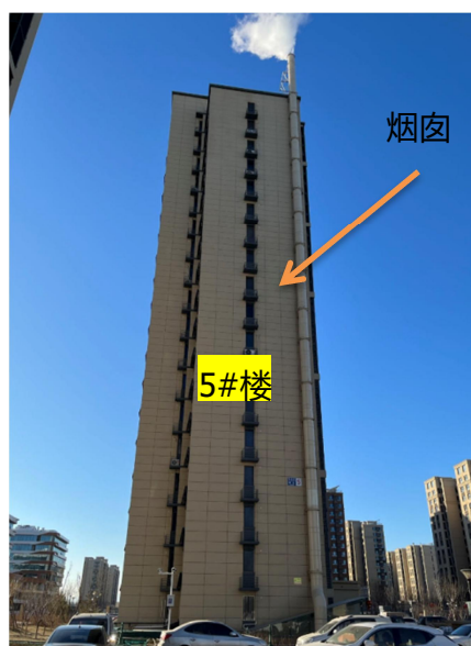
项目锅炉排气烟囱
