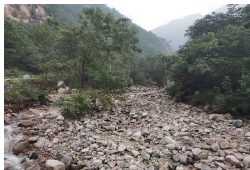
河道阻塞（上下口沟）
