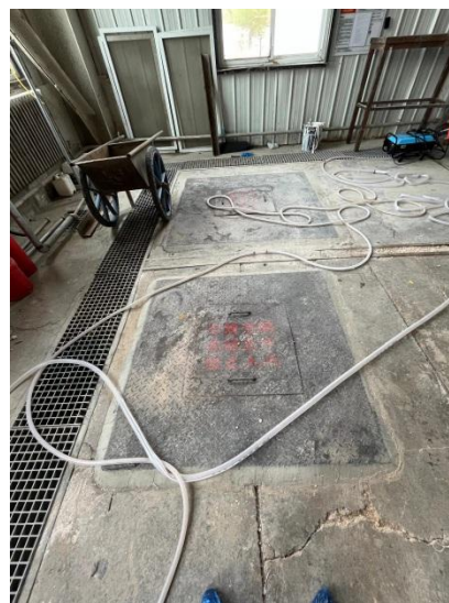
原料石块清洗废水沉淀池
