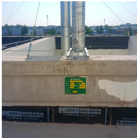
刷瓶机（配套净化装置）及废气排放口
