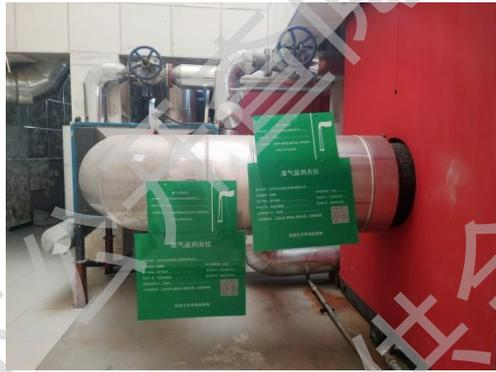
图3.3 燃气锅炉废气排放口和监测点位环境保护图形标志牌（3#）
