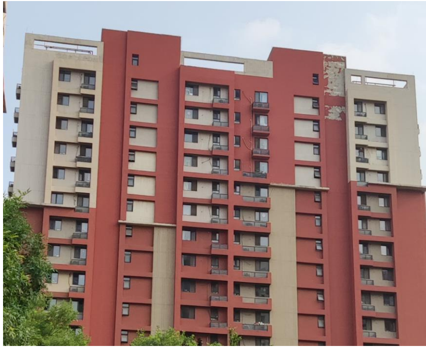
图 6-7 金地格林格林小区外窗照片
