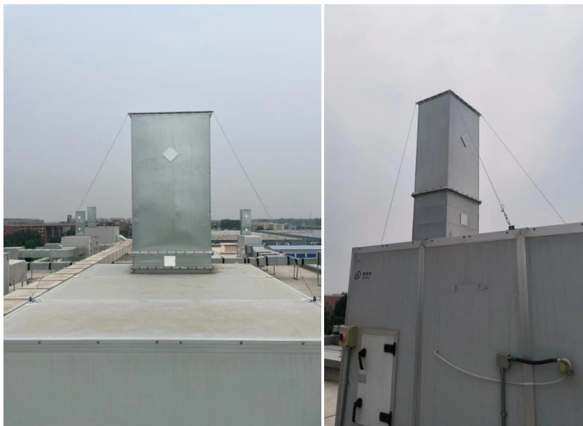
废气采样口照片
