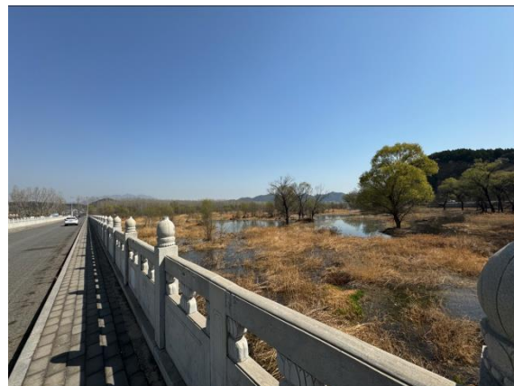
终点怀水大桥（河道桩号K35+750）现状
