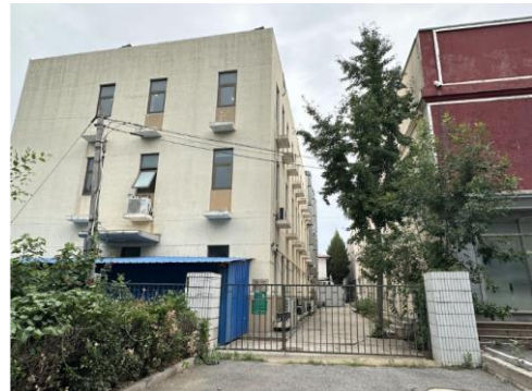
医院污水总排口位置
