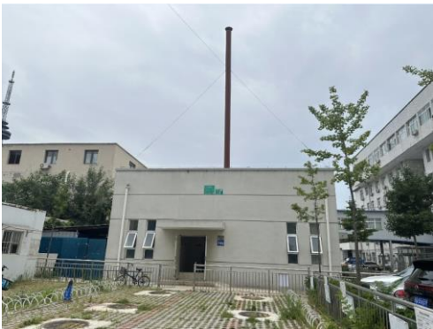
污水站站房及排气筒
