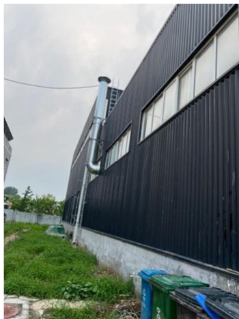
项目厂房南侧
