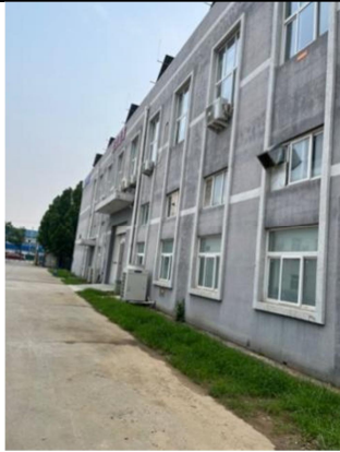
项目南侧 7#厂房
