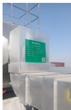
焊烟废气净化装置及排气筒（DA002） 焊烟废气监测点位标识（DA002）
