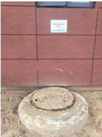
厂区生活污水总排口
