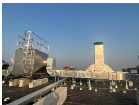
焊烟废气净化装置及排气筒（DA002） 焊烟废气监测点位标识（DA002）
