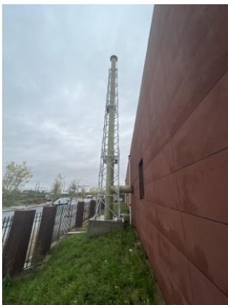
恶臭废气排气筒（DA001） 恶臭废气监测点位及排放口标识（DA001）
