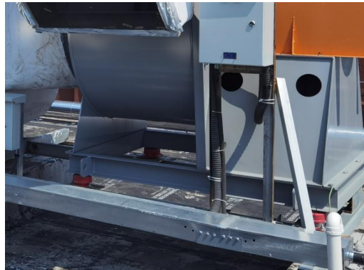
风机减振装置
